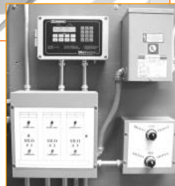
Instalacja zespołu SMU (wyżej) i interfejsu HMI (obok) SiloPatrol™ w instalacji przeróbki tworzyw sztucznych
