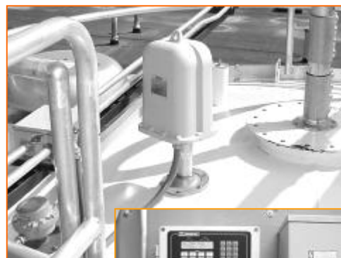
Instalacja zespołu SMU (wyżej) i interfejsu HMI (obok) SiloPatrol™ w instalacji przeróbki tworzyw sztucznych
